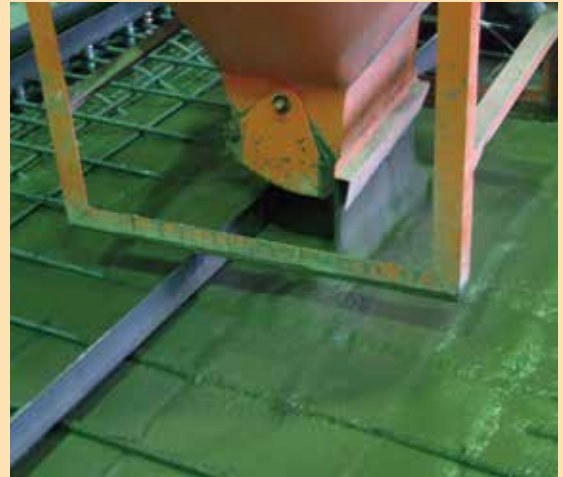
ESCONスラブの打設状況
